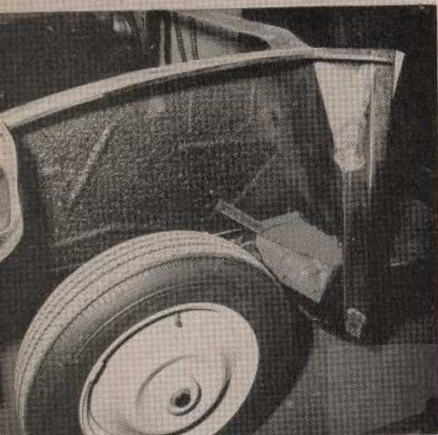
Fig. 4. — Pose d'une nouvelle planche à talon (soudure à l'arc).
