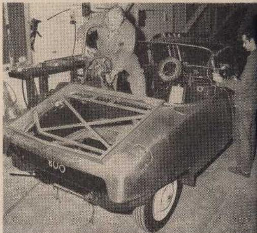
Fig. 22. — Gabarit servant au positionnement de l'encadrement (gouttière) de porte de coffre pendant le soudage du revêtement.
